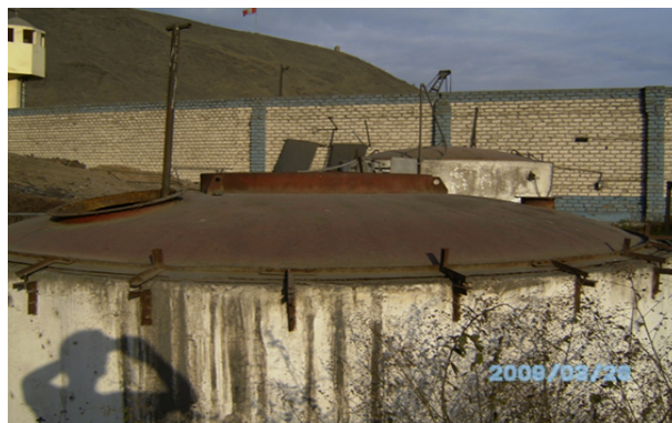
Figura 32: Biodigestor de mecánica.
