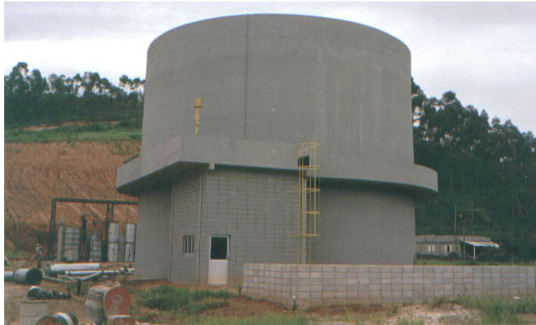
Figura 9: Biodigestor Batch Grande
