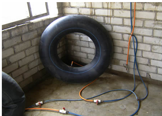
Figura 15: Cámaras de camión utilizadas para almacenar biogás.
