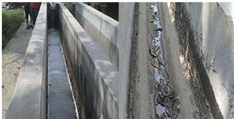
Figura 27: Canal A y B del desarenador.
