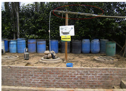
Figura 16: Sección más ancha de la tubería, donde se introduce la viruta de hierro.
