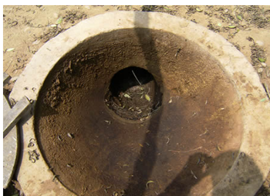
Figura 21: Orificio de alimentación del biodigestor de Casa Blanca.
