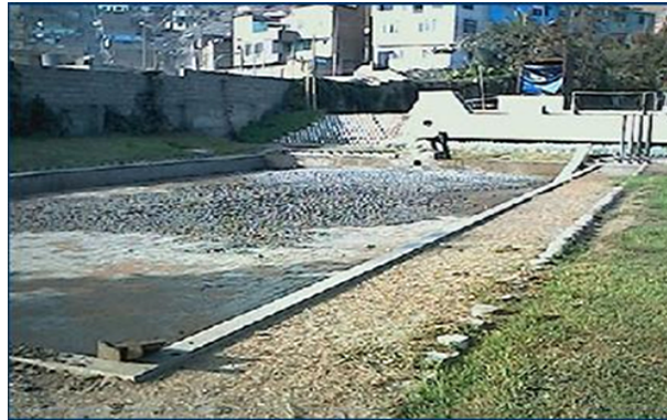
Figura 31: Lecho de secado de lodos.
