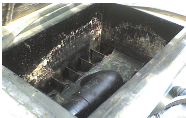
Figura 29: Distribuidor de caudal ubicado en la parte superior del RAFA.
