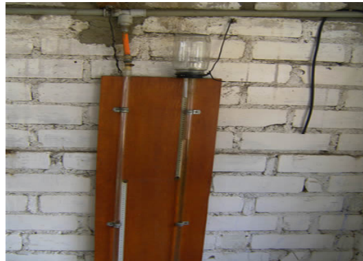
Figura 14: Válvula de seguridad de 150 milibar.
